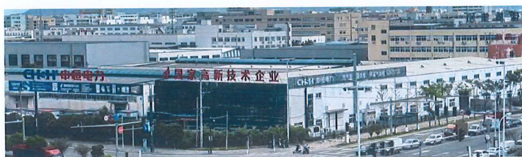
浙江省温州市乐清市乐清经济开发区中心大道 261 号 厂房概貌
